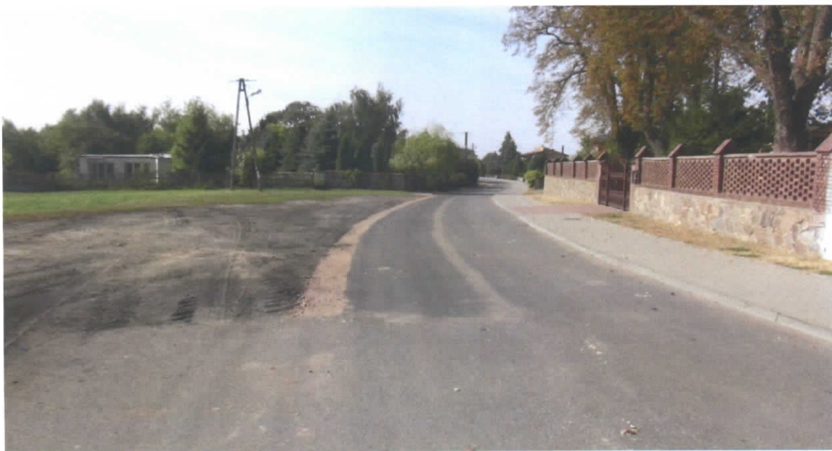
Poszerzenie drogi w Kaszewach Kościelnych
