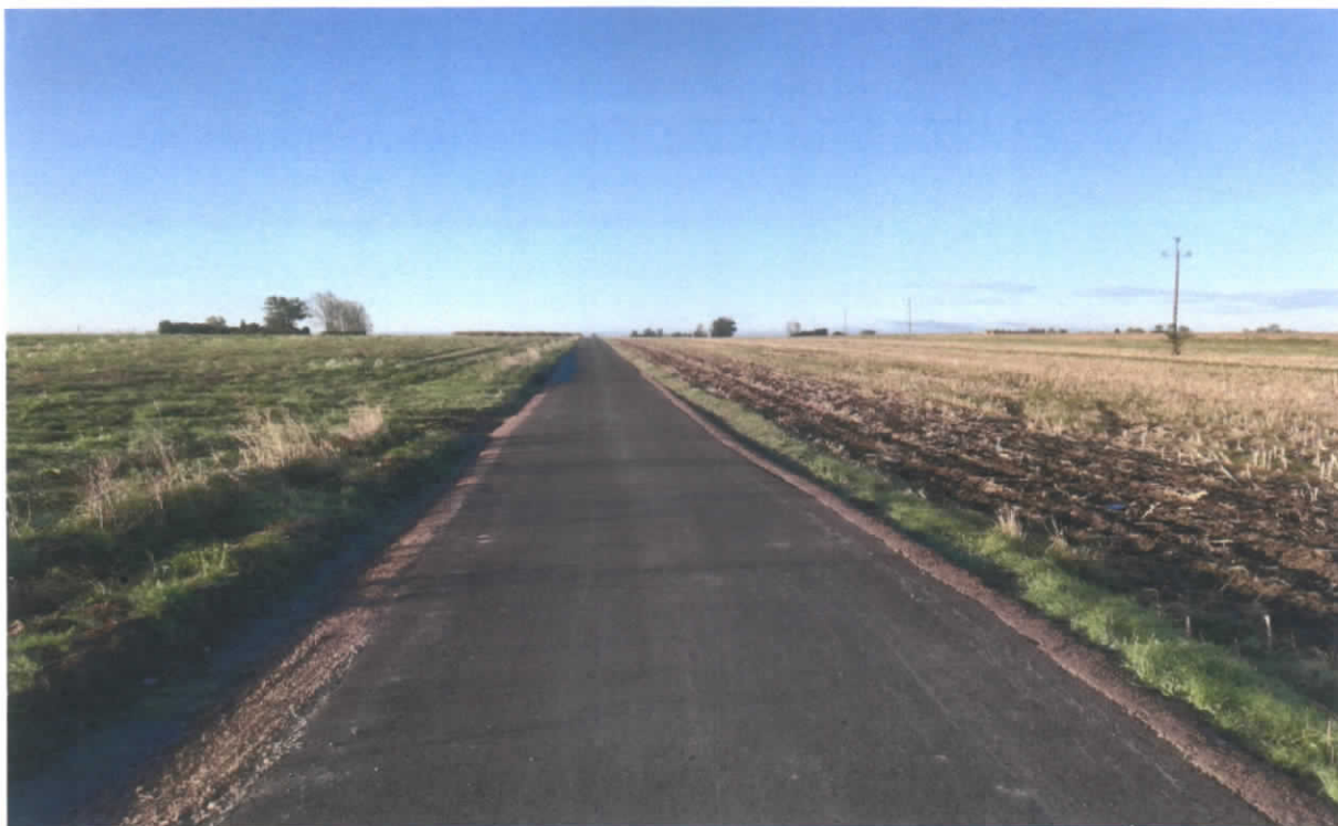
Droga w Łękach Kościelnych
