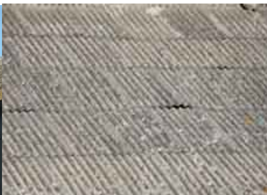
Rys.5 Płyty faliste - eternit
